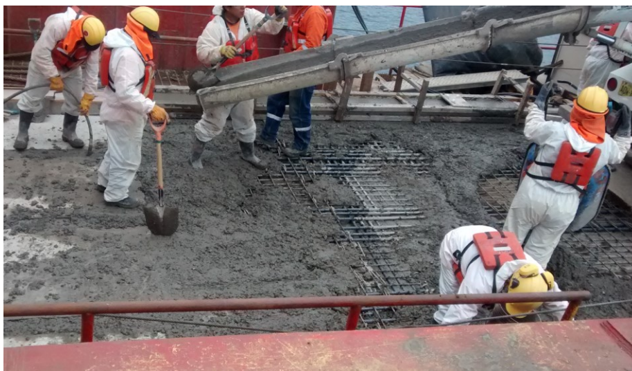
Figura 11 – Detalhe da concretagem “in-loco” (a imagem não é do berço em questão, sendo apenas uma exemplificação do procedimento a ser realizado).
