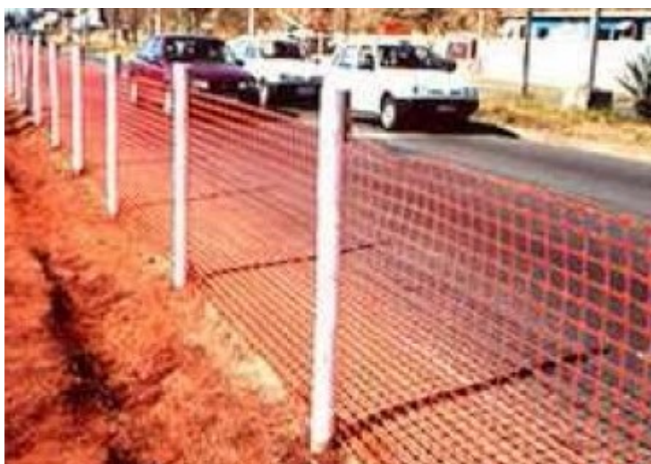
Figura 7 – Isolamento com tela plástica (Fonte: SINAPI)
